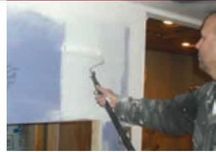
Applying primer to new drywall.
