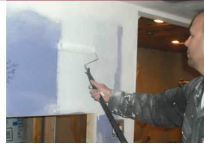
Applying primer to new drywall.
